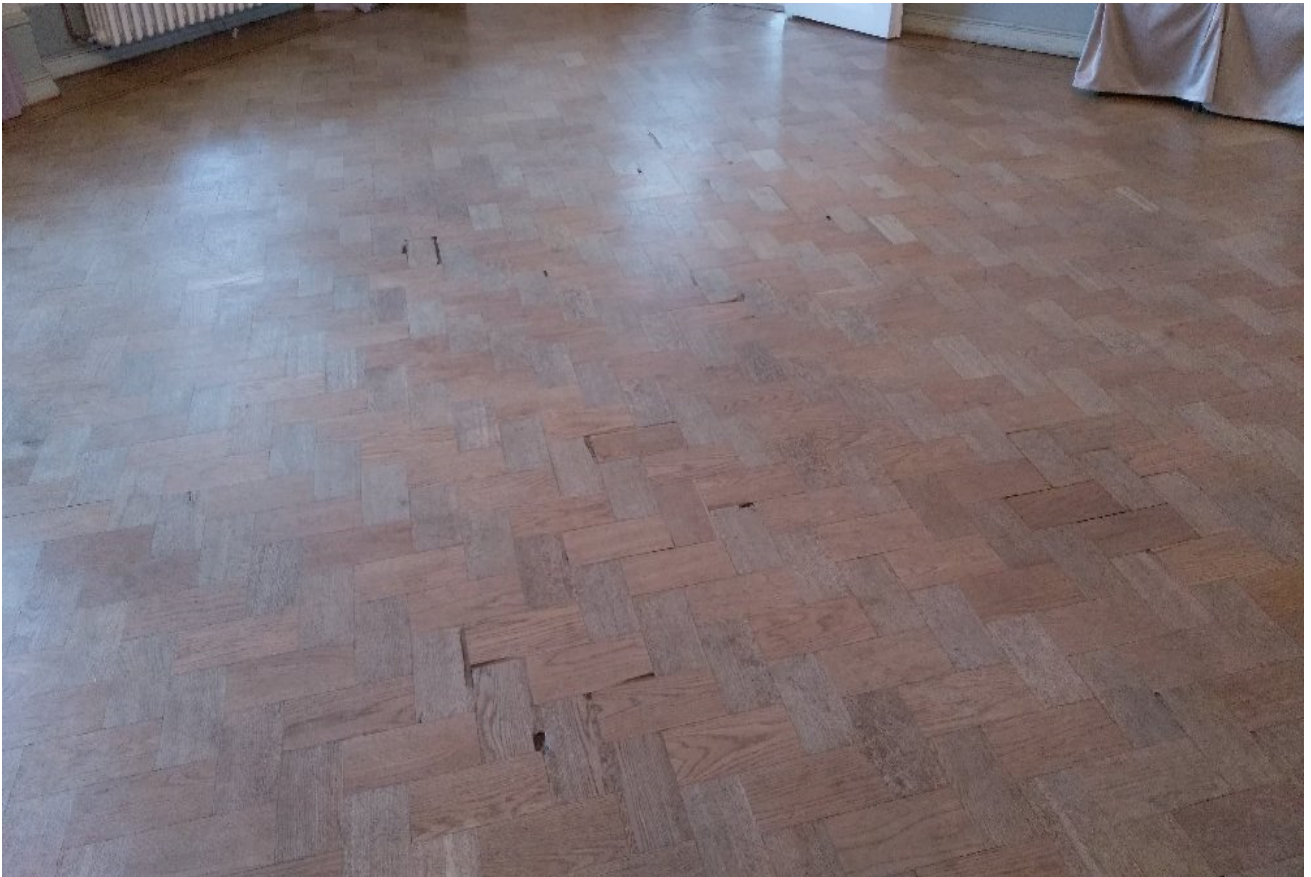
FOTO 1. Saali põranda üldvaade
